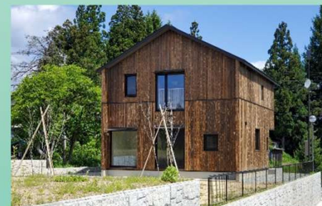
山形県の高断熱省エネ住宅
