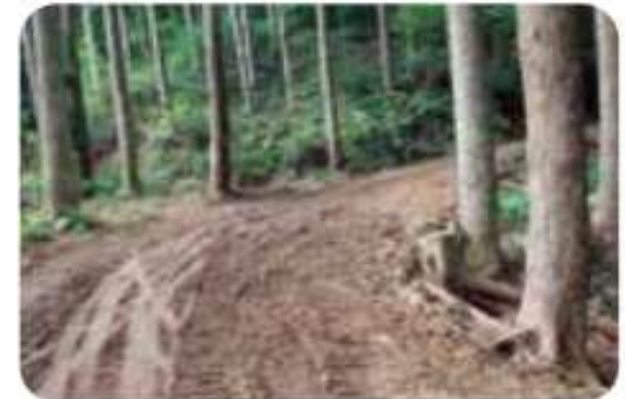
復旧した森林作業道
