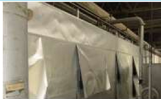
焼成炉の保温施工を実施し、炉表面からの熱放散を防止
